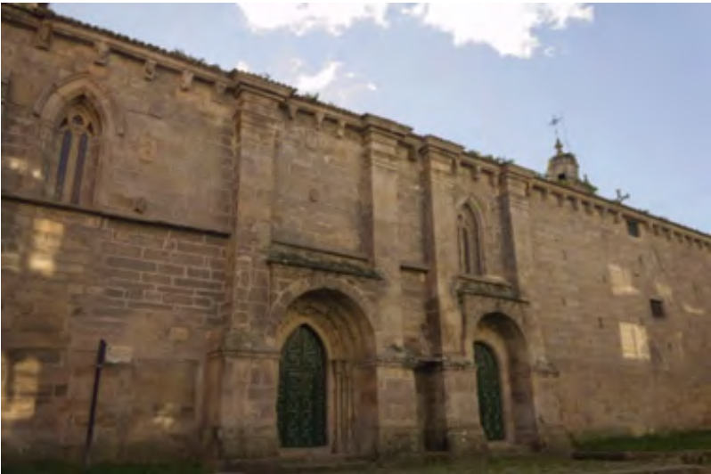
El muro norte del convento con las dos puertas
